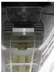
14-Mise en eau pour vérification de l'étanchéité. Au préalable le barrotage de plancher a été repris et l'ensemble peint à une couche de minium et deux couches de
