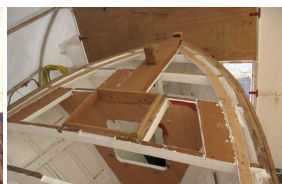
13-La plage avant après réfection, cloison du puits aux chaînes en place. Cette dernière, comme les planchers et quasiment tous les éléments en contre-plaqué ont dus être remplacés du fait du délaminage du contre-plaqué d'origine.
