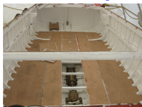
15-Vue de l'arrière, planchers et ligne d'arbre en place. Reste à poser les cloisons arrière et milieu ainsi que les réservoirs avant de commencer le montage du pont.
