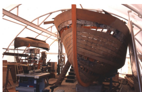
1 - Réfection de la préceinte, des membrures, de l'étrave et de la quille terminés on attaque les bordés.
