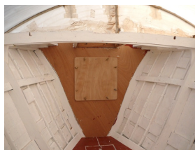
16-Vue de l'avant, cloison et panneau du puits aux chaînes en place.
