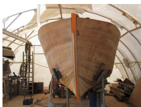
2 - Coque en cours de flipotage
