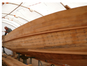
3 - Coque terminée, entièrement flipotée sauf la rablure qui est calfatée; ailerons de stabilisation et ceinture extérieure remplacés. Cette image permet de voir les bordés remplacés sur bâbord
