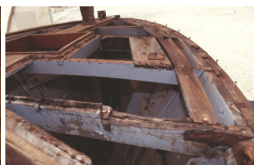
12-Vue de la plage avant après démontage du pont. Seuls le surbau du panneau avant, deux barrots de pont et la bitte seront récupérables dans ce secteur.
